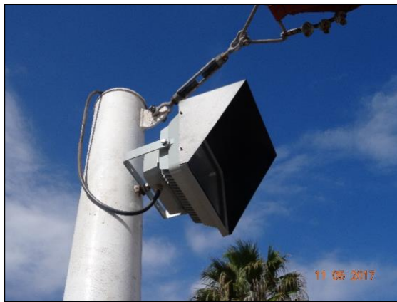
Imagen 5. Vista General de la luminaria, es posible constatar la presencia de para lumen o visera, cuando corresponda.
