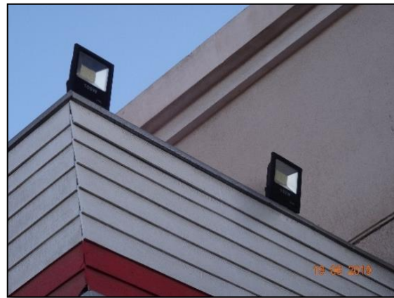
Imagen 6. Vista de luminarias instaladas de manera incorrecta, con ángulo de enfoque que propiciaría emisión hacia el hemisferio superior, sin para lumen.
