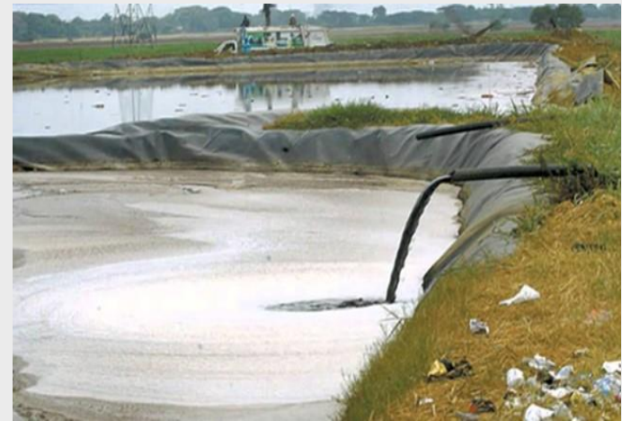
Sistema de manejo de lixiviados
