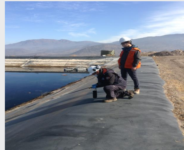
Medición nivel piscina de lixiviados
