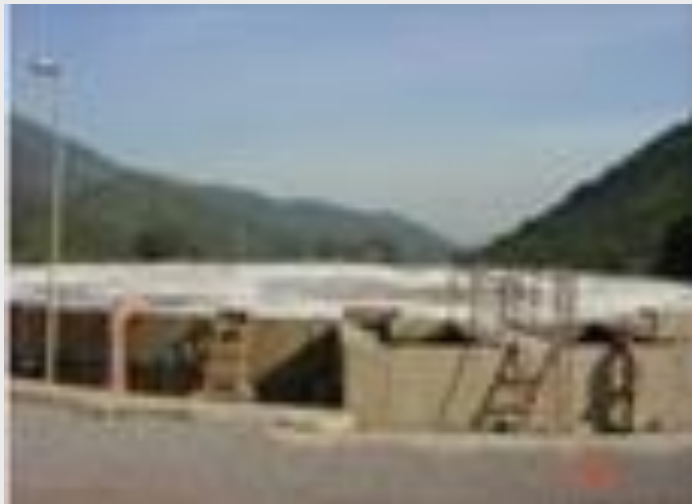
Tratamiento de lixiviados
