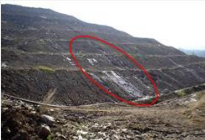
Afloramientos de lixiviados
